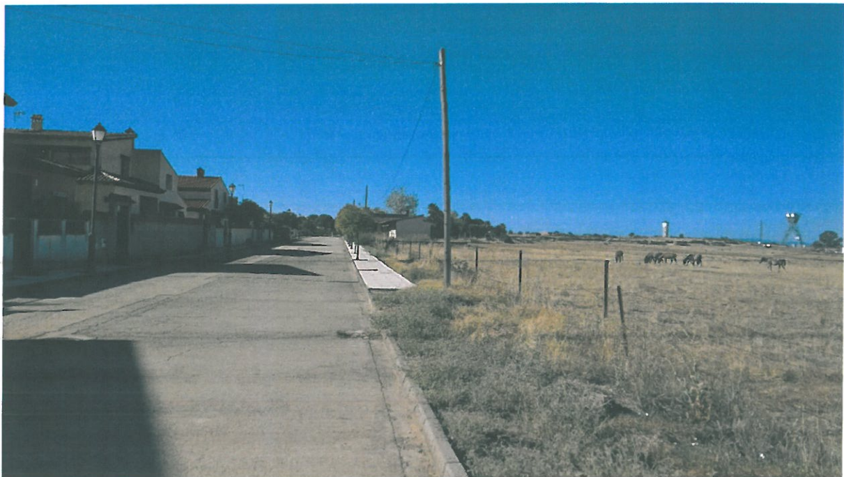
Vía urbana en Las Eras (M02).
